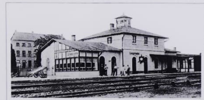
Der Bahnhof nach seiner Erweiterung um 1910
